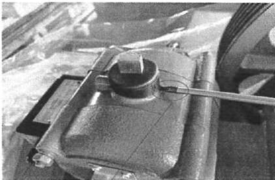
用十字螺丝刀拆除松闸杆的定位螺钉
